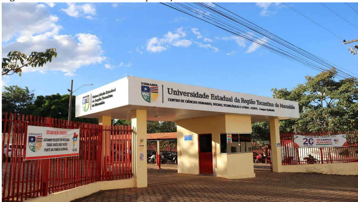
Figura 9 - Fachada do Prédio no Campus Açailândia .
