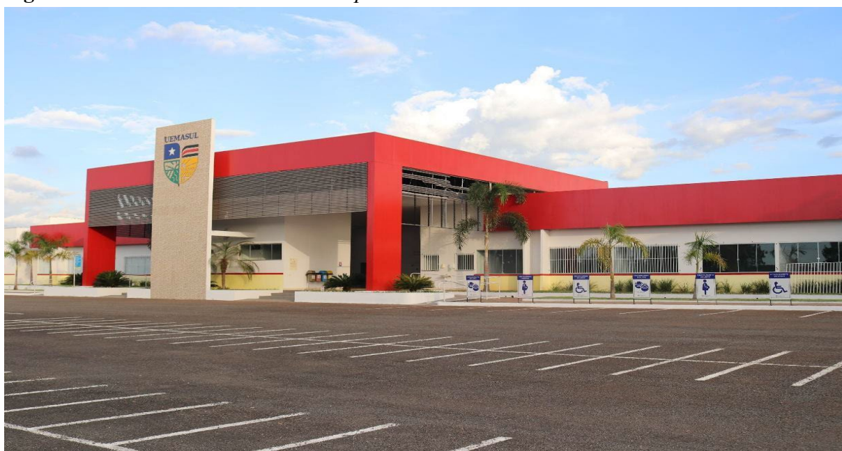
Figura 10 - Fachada do Prédio no Campus Estreito .
