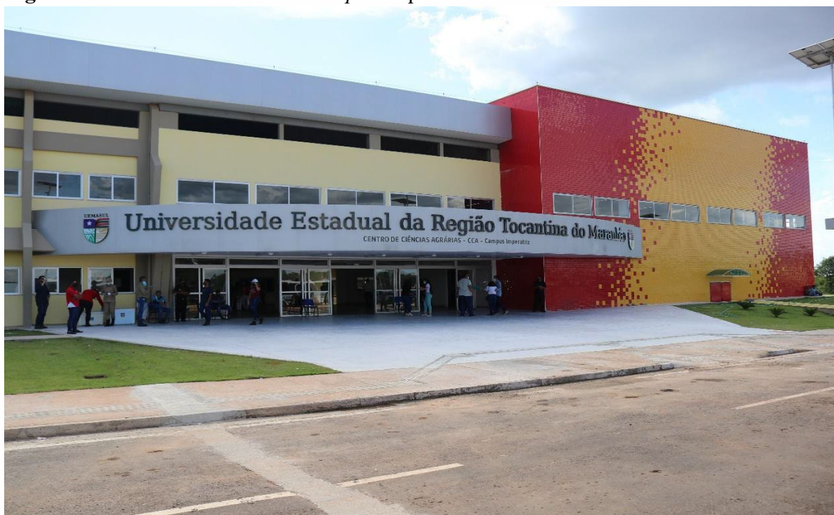
Figura 8 - Fachada do Prédio no Campus Imperatriz CCA .
