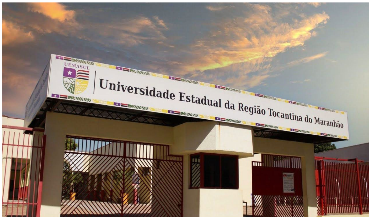
Figura 7a - Fachada do Prédio I no Campus Imperatriz Centro .
