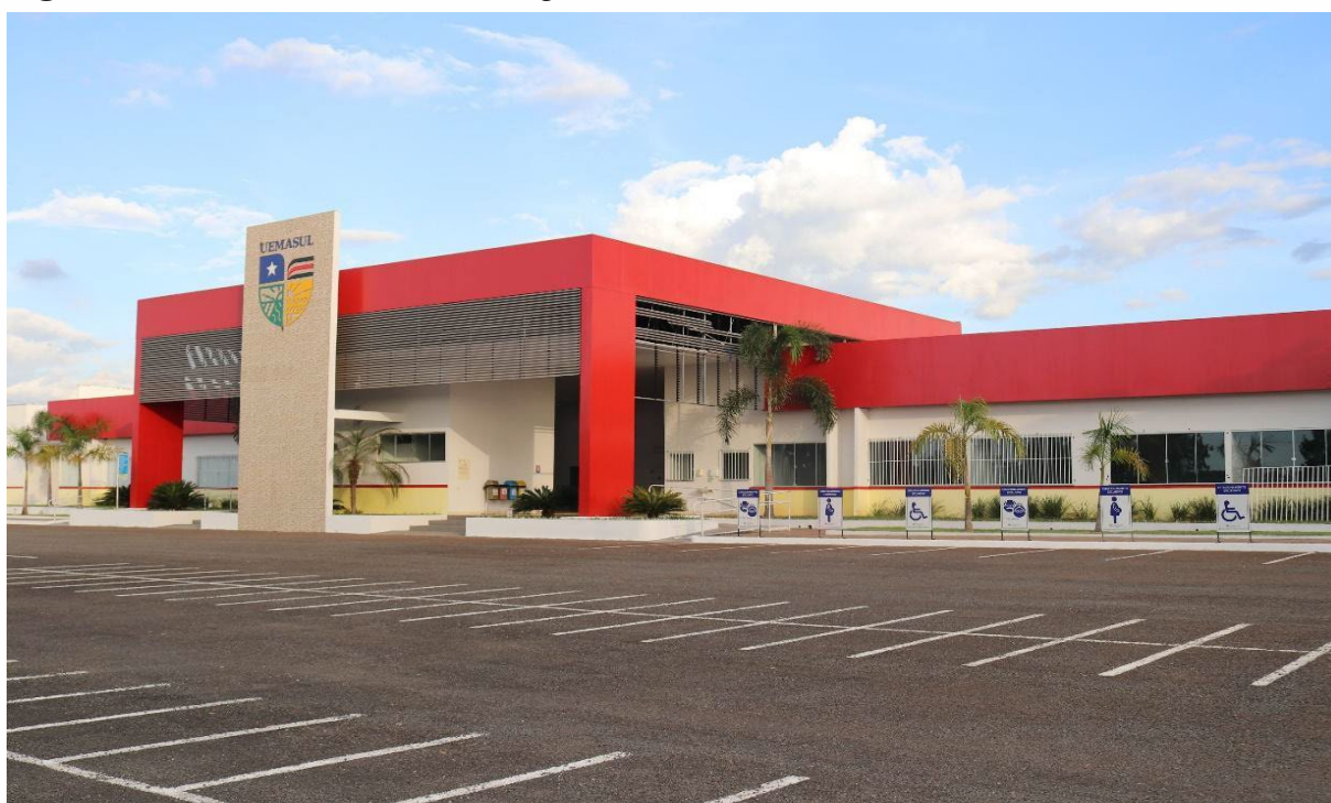
Figura 5 - Fachada do Prédio no Campus Estreito.
