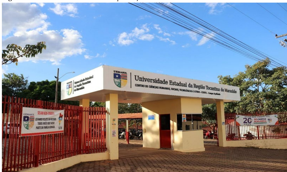
Figura 4 - Fachada do Prédio no Campus Açailândia .
