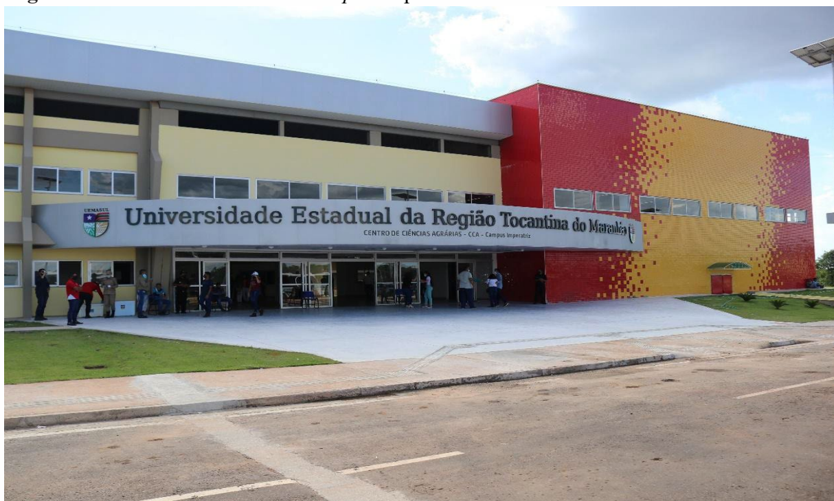
Figura 3 - Fachada do Prédio no Campus Imperatriz CCA .
